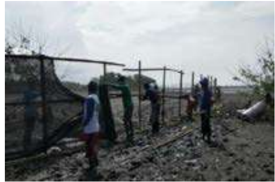
Gambar 3. Kegiatan pemasangan APO
