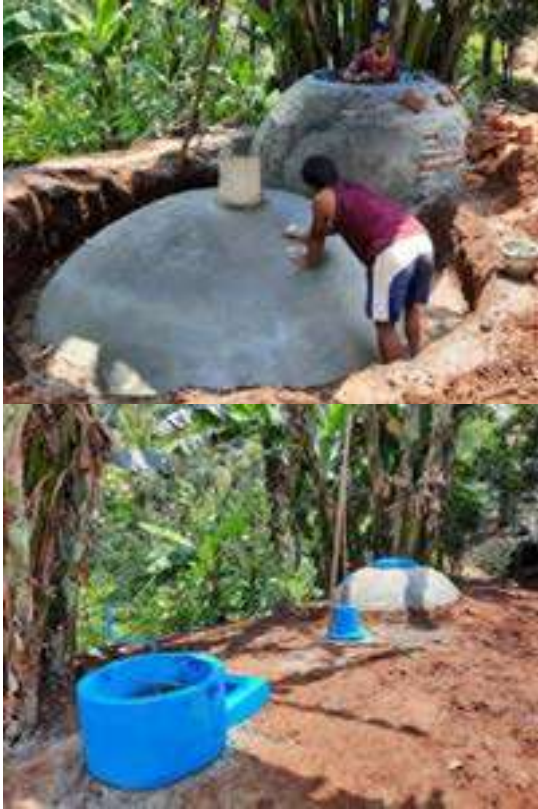
Gambar 1. Pembuatan digester
